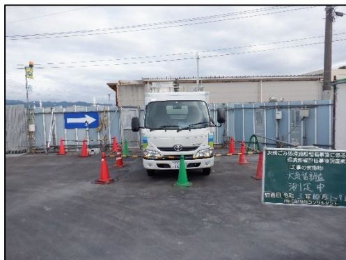
(建設機械の稼働 令和3年10月)
