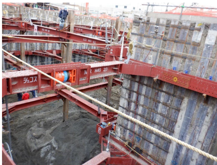
写真 4.6.2-1 山留工事の状況
