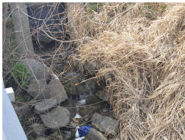
(轟木川への放流口)
