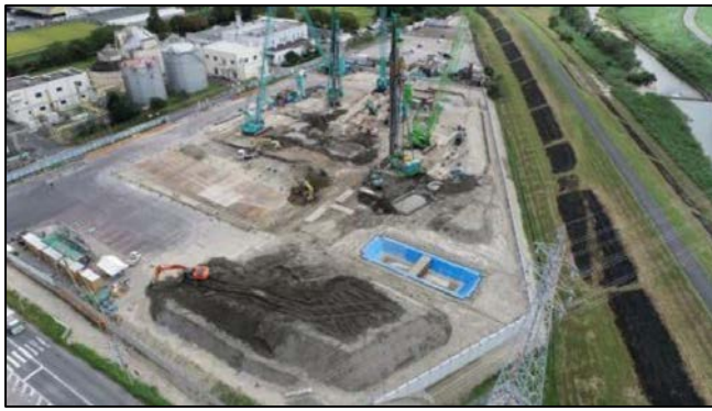
工事の状況（令和3年9月30日）
