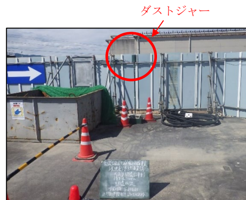
(造成等の施工 令和3年9～10月)
