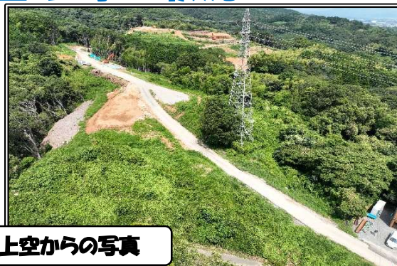
搬入道路(ブロック積埋戻し中)
