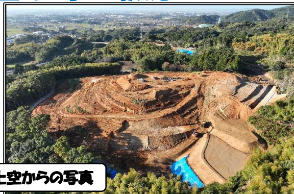
搬入道路(補強土壁床掘中)
